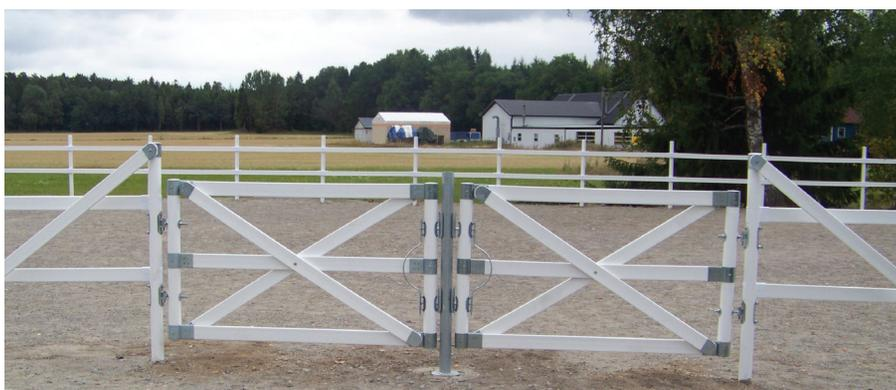
Exemple de paddock avec portail double et 2 rangées de planches. Piquets de 220 cm de hauteur (nous recommandons l'enfoncement de 80 cm dans le sol).
